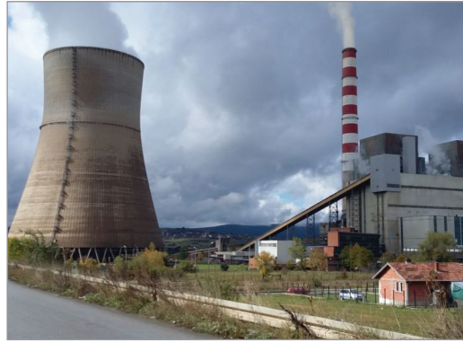
TERMOCENTRALI “KOSOVA B”
