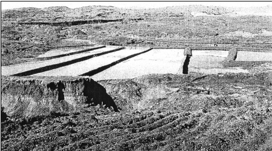
Fig.71. Depozita e hirit e TC “Kosova B” me sistem hidraulik të transportit me hedhje të hirit në hapësirën e shfrytëzuar në minierën Mirash.
