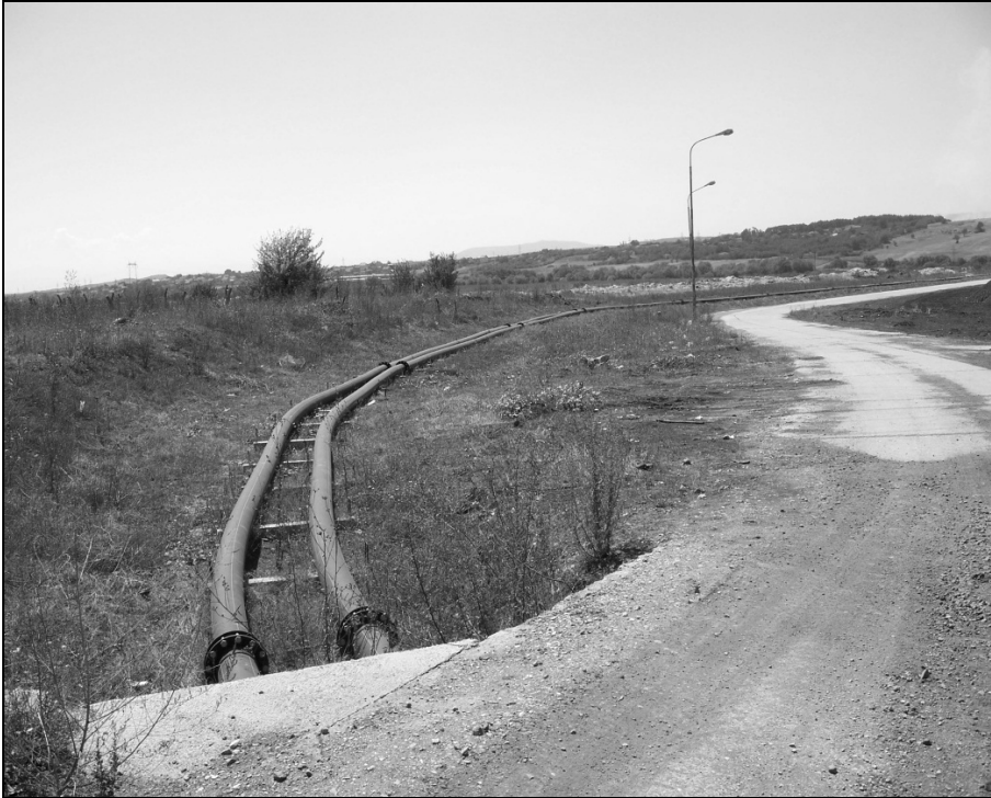
Fig.72. Bartja hidraulike e hirit me gypa plastike.
