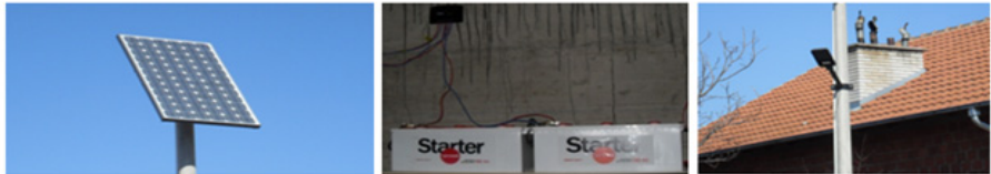
Fig. 7 Ndrçimi i oborrit në Skënderaj (2 akumulatorët në garazh, 12V, 180Ah, Starter )
