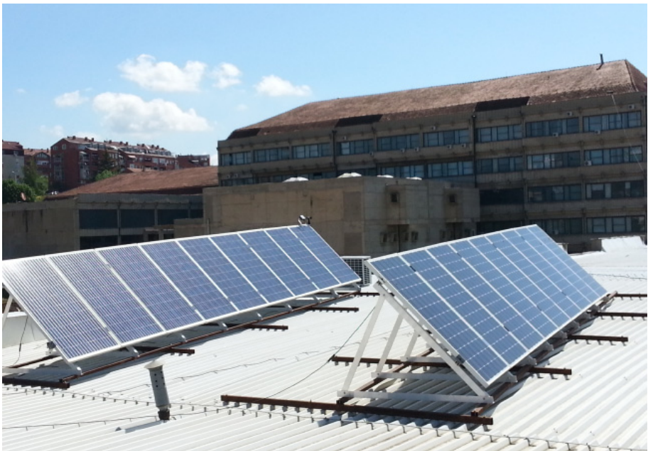
Fig. 3 Panelet fotovoltaike në kulm të objektit dhe pajisjet e tjera në laborator
