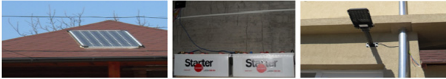
Fig. 6 Ndrçimi i rrugës në Skënderaj (2 akumulatorë, 12V, 180Ah, Starter VESNA)
