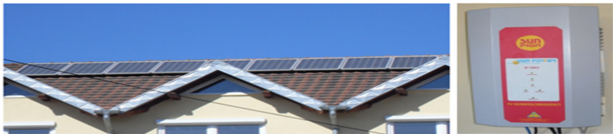
Fig. 8 Panelet diellore të montuar në catin e shtëpisë dhe inventori DC/AC
